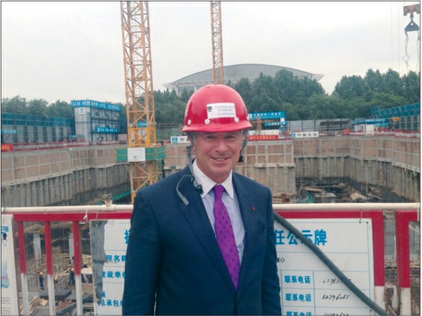
De volta ao início, construindo a Faculdade Schwarzman a partir de suas fundações, em 2014.
